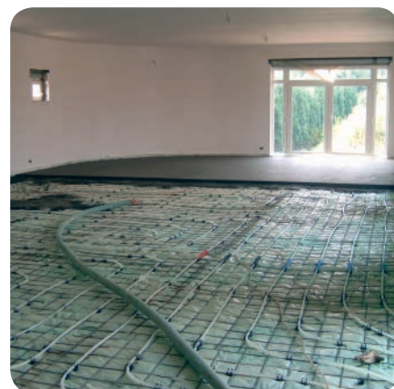
Afgewerkte vloer met Thermogran, vloerverwarming en chappe.
